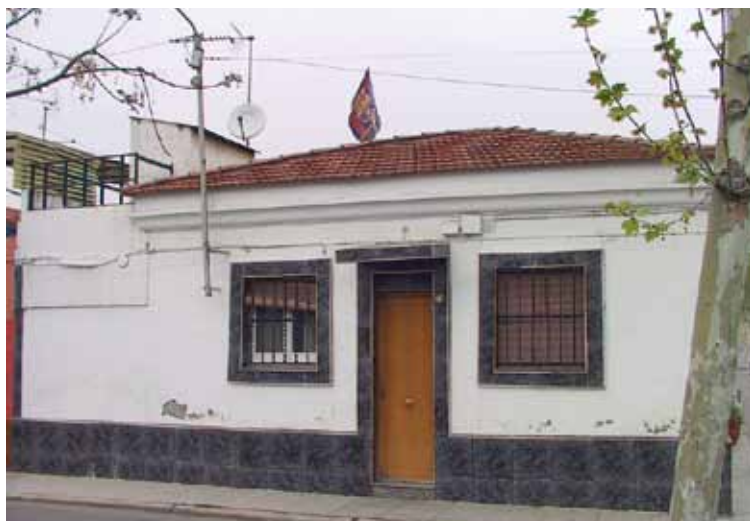
Les casas baratas sont de petites maisons de ville de plain-pied construites en briques qui disposent de surfaces habitables de 35 à 60 m 2
